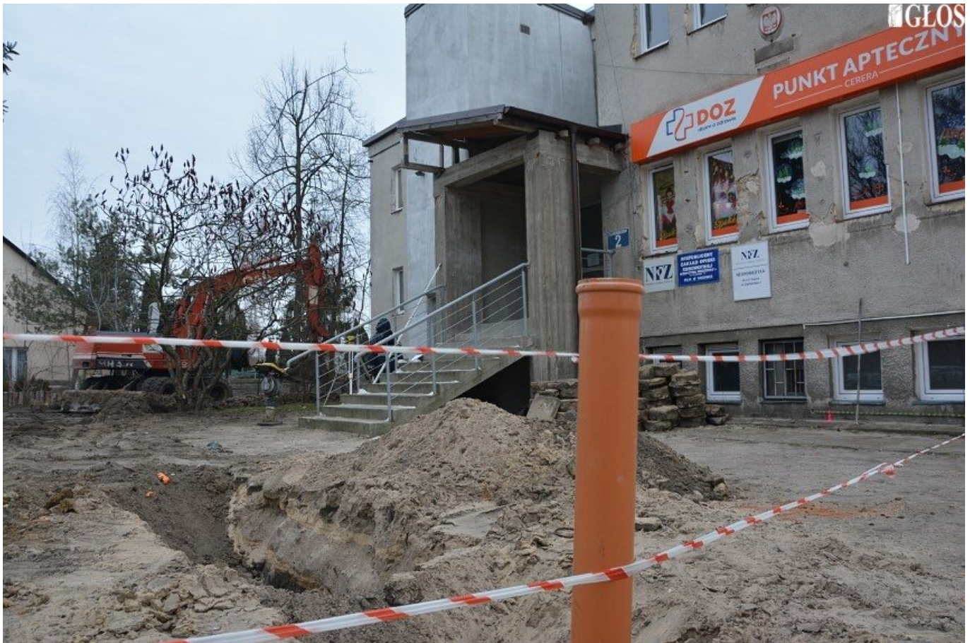
Przy przychodni zdrowia Guzowie widać prace ziemne. (Fot. Włodzimierz Szczepański)
