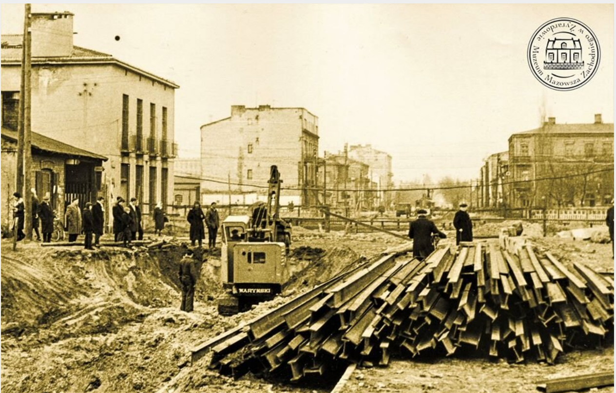
Budowa tunelu i wiaduktu kolejowego na ul. 1-Maja. (fot. Muzeum Mazowsza Zachodniego)
