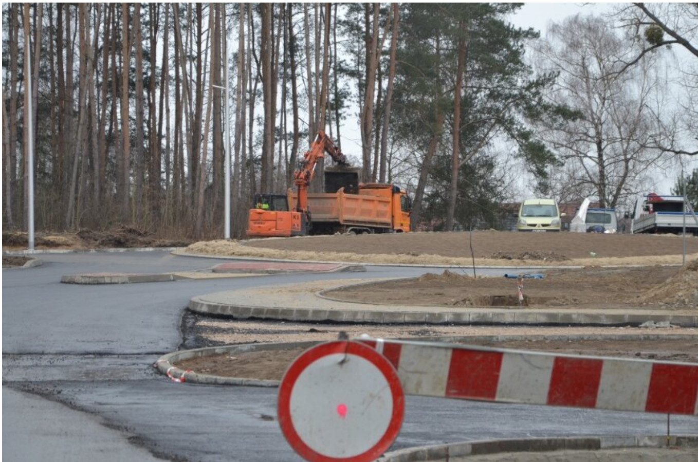
Budowa drogi dobiega końca, finał w lipcu tego roku. (Justyna Napierała)
